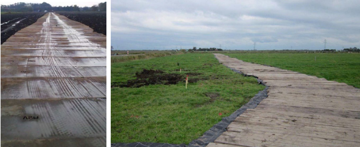
Abbildung 17: Beispiele für Baustraße mit Lastverteilungsmatten (Stahl und Holz auf Vlies)
