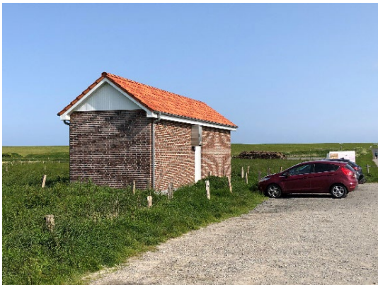
Abbildung 1: Repeaterstation Hilgenriedersiel, hier als Beispiel
