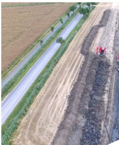
2015: Während der Bauphase
