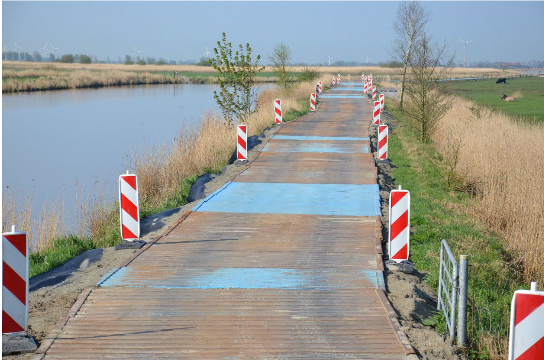
Abbildung 16: Provisorische Zuwegung als Plattenzufahrt bei einer Freileitungsbaustelle
