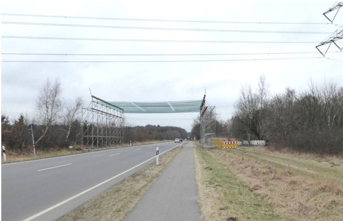
Abbildung 12: Schutzgerüst
