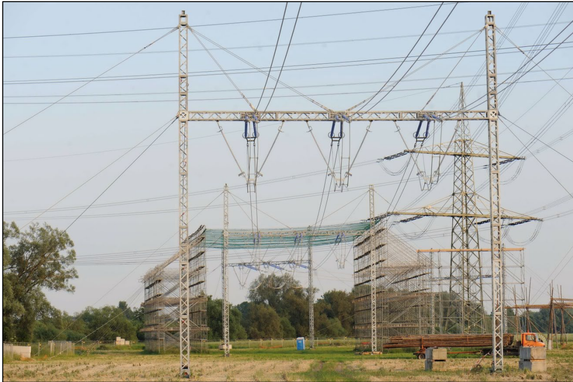
Abbildung 14: 380-kV-Freileitungsprovisorium für ein System (mit errichtetem Schutzgerüst)
