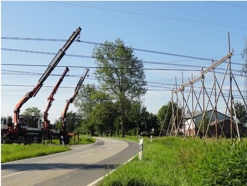
Abbildung 13: Schutzgerüst in Leichtbauweise
