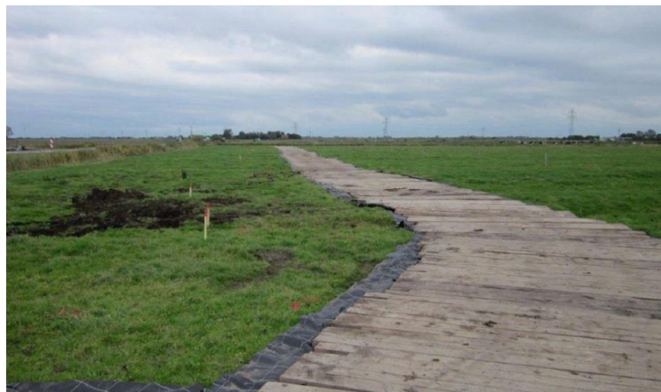
Abbildung 19: Beispiele für Baustraße mit Lastverteilungsmatten (Stahl und Holz auf Vlies)
