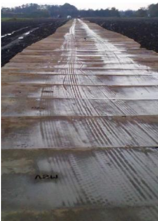
Abbildung 19: Beispiele für Baustraße mit Lastverteilungsmatten (Stahl und Holz auf Vlies)
