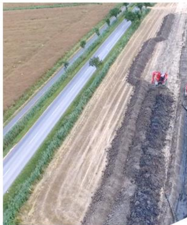
2015: Während der Bauphase
