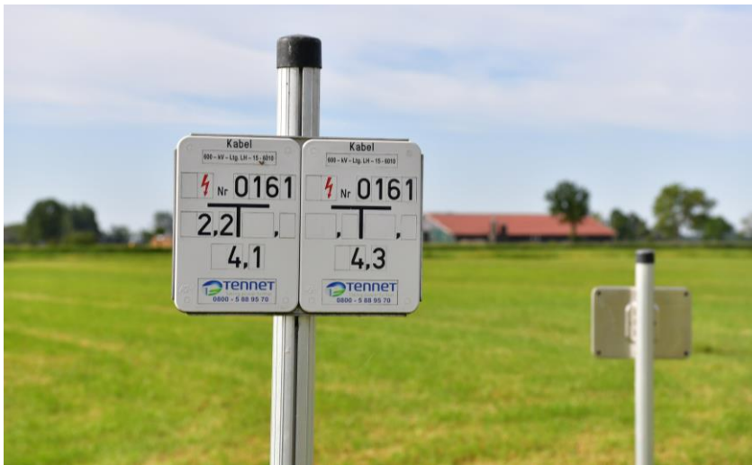
Abbildung 36: Beispiel eines Dükerschildes
