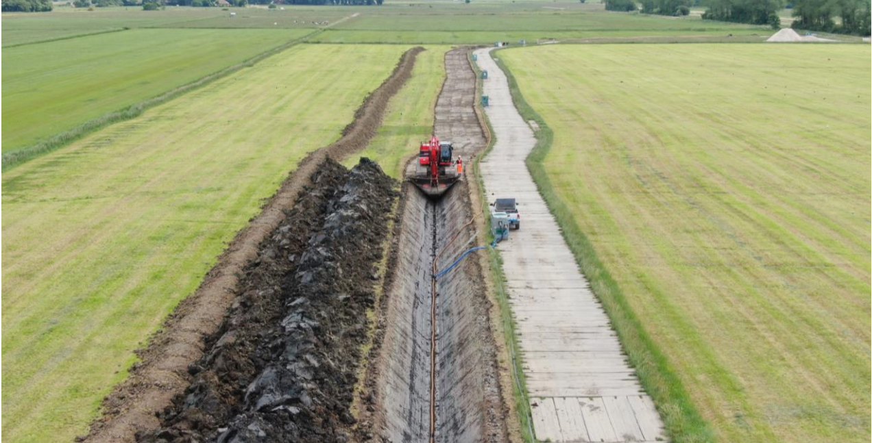
Abbildung 21: Beispiel Herstellung offener Kabelgraben (mit Baustraße und Bodenlager mit Bodentrennung)
