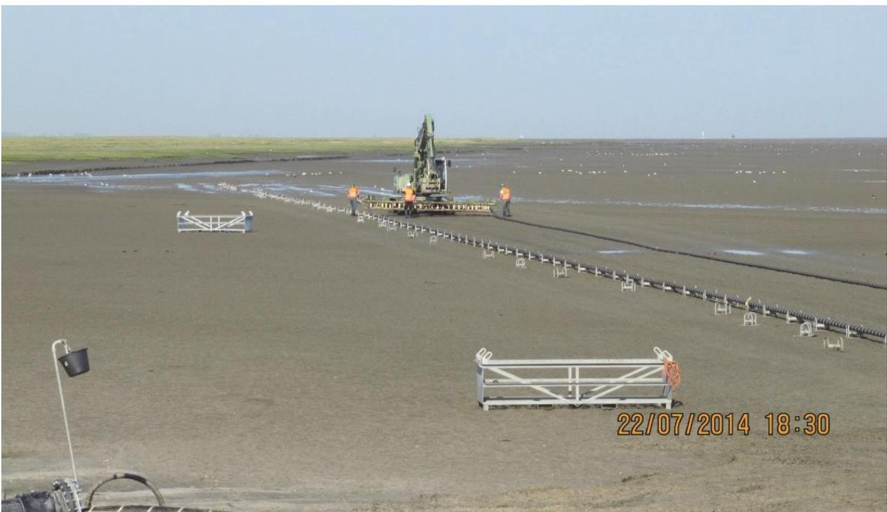
Abbildung 18: Auslegung der Kabelschleife (Quelle: eos projekt)
