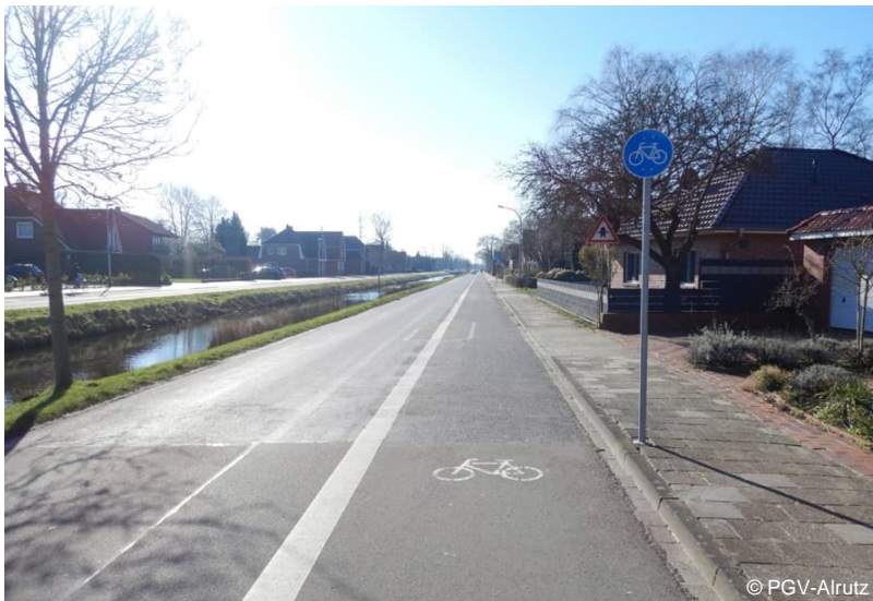
Radfahrstreifen in einer Ortsdurchfahrt
