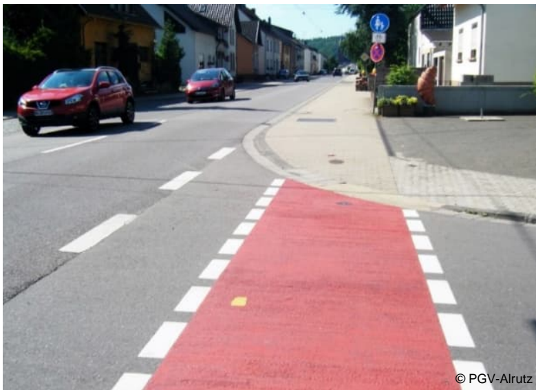
Gehweg mit zugelassenem Radverkehr in einer Ortsdurchfahrt
