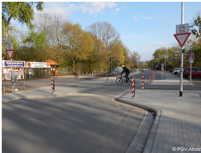
Betonung des Vorrangs der Radverkehrsverbindung durch deutliche Fahrbahneinengung und Aufpflasterung
