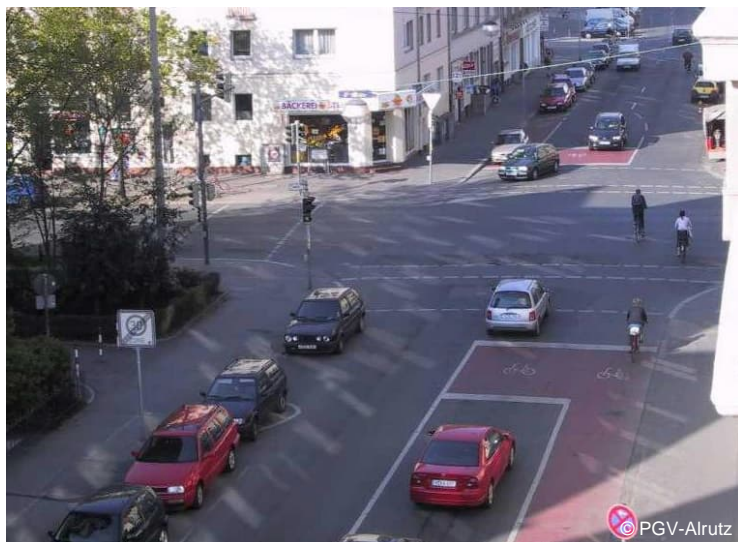
Aufgeweiteter Radaufstellstreifen mit Aufstellmöglichkeit zum Linksabbiegen und Geradeausfahren vor dem Kfz-Verkehr
