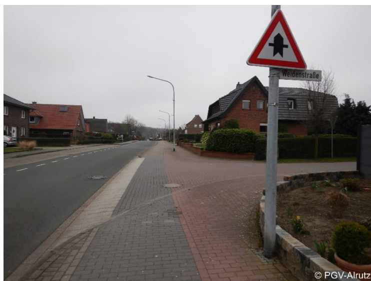
Rad- und Gehwegüberfahrt mit Rampenstein
