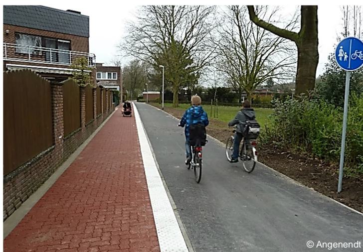
Getrennter Geh- und Radweg. Trennung der Verkehrsarten durch einen taktil erfassbaren Trennstreifen
