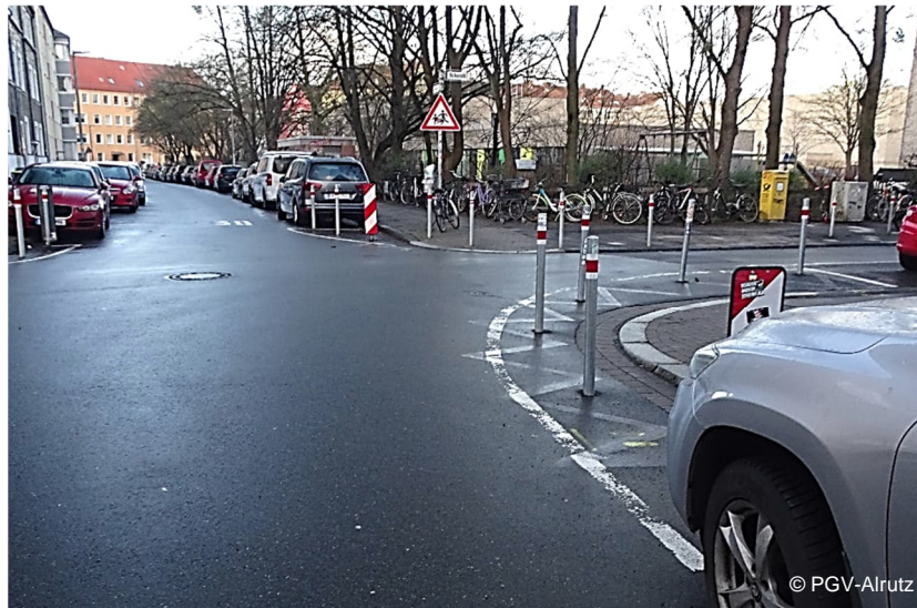
Freihalten der Eckbereiche eines Rechts-vor-Links-Knotenpunktes durch Pfosten
