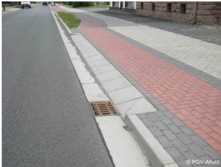
Baulicher Einrichtungsrادweg mit Radwegüberfahrt an einer Grundstückszufahrt
