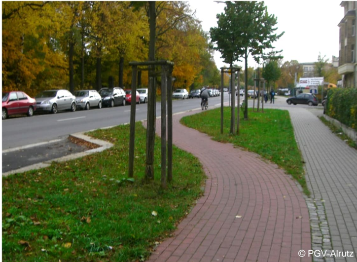
Heranführen eines Radwegs an die Vorfahrtstraße, um die Sichtbeziehungen zwischen rechtsabbiegenden Kfz und Radverkehr zu verbessern
