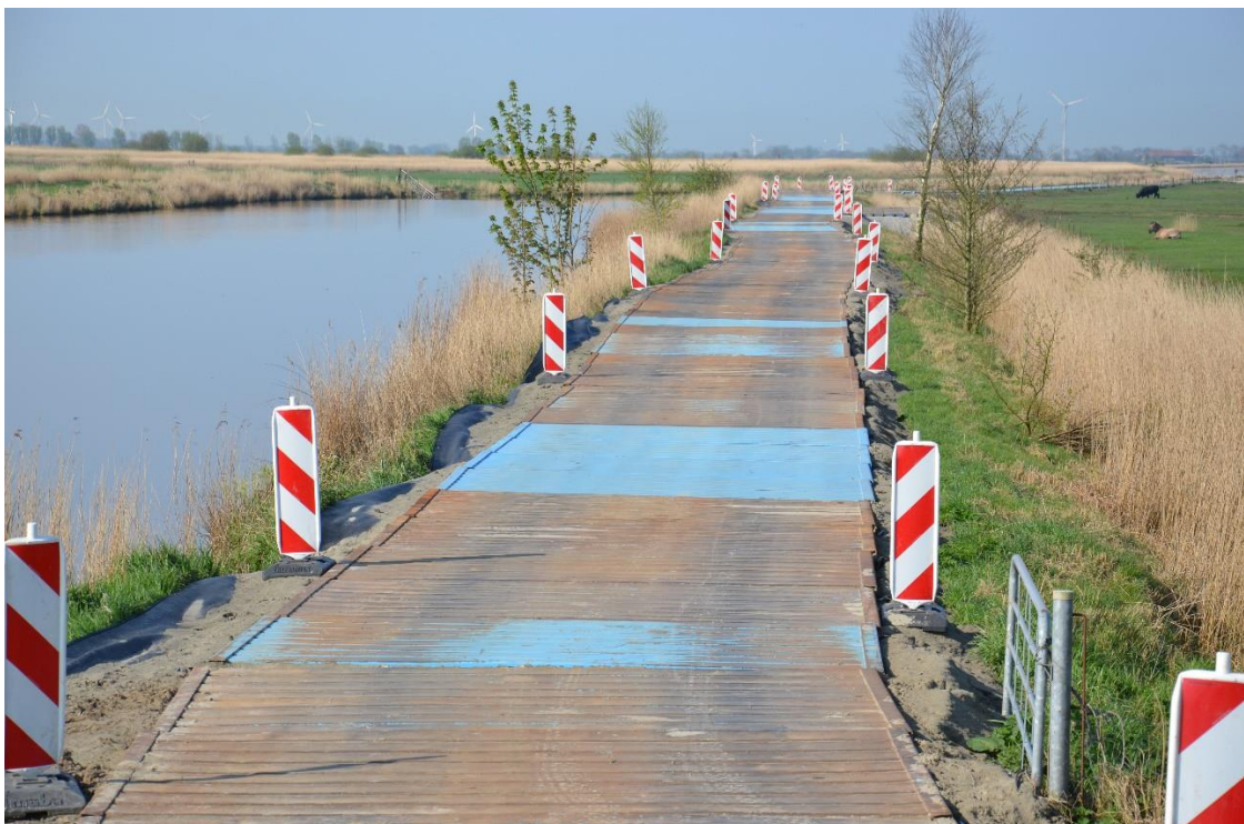
Abbildung 16: Provisorische Zuwegung als Plattenzufahrt bei einer Freileitungsbaustelle
