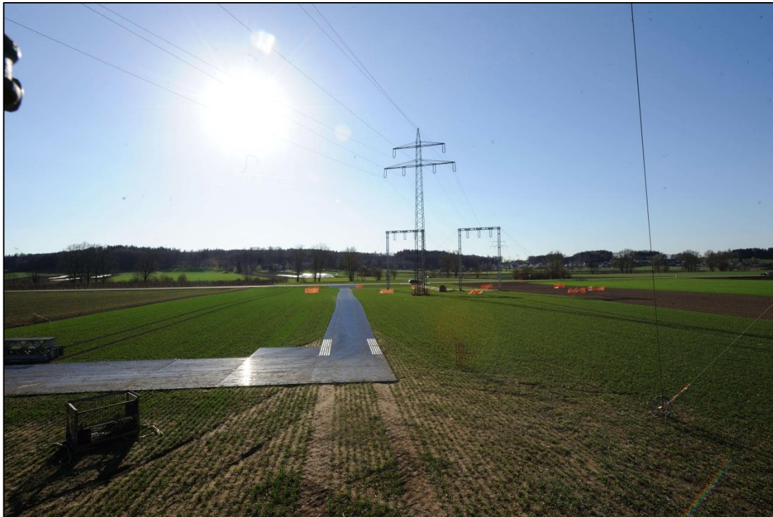
Abbildung 11: Baustraße als Plattenzufahrt bei einer Freileitungsbaustelle
