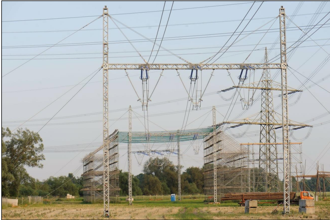
Abbildung 14: 380-kV-Freileitungsprovisorium für ein System, mit errichtetem Schutzgerüst
