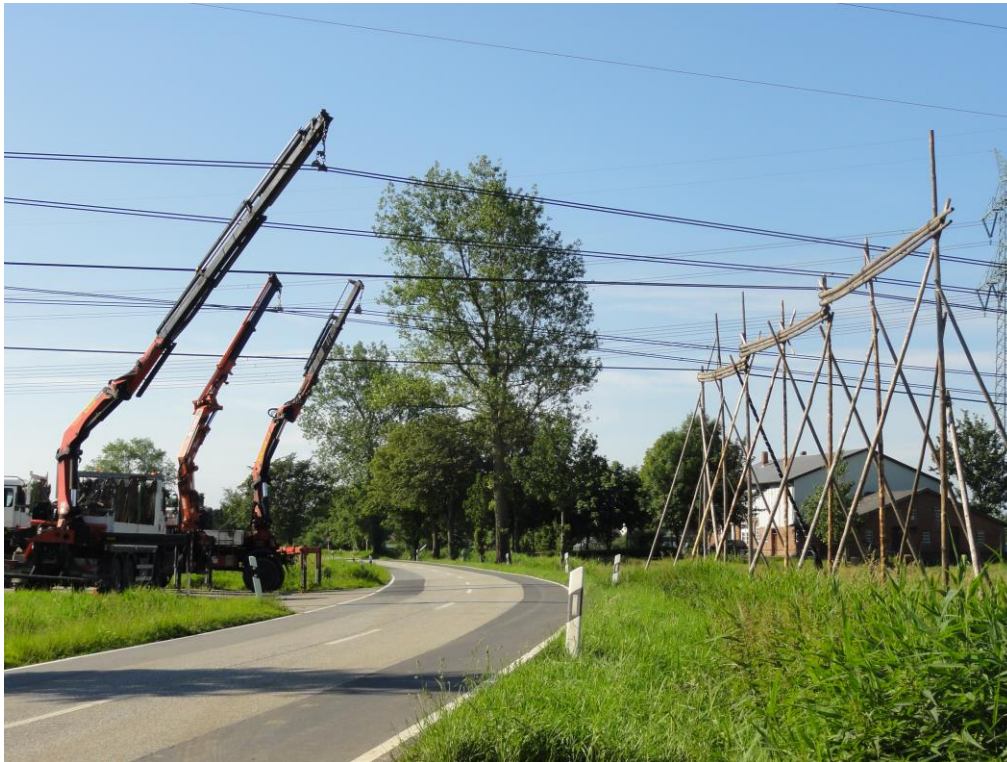
Abbildung 13: Schutzgerüst in Leichtbauweise
