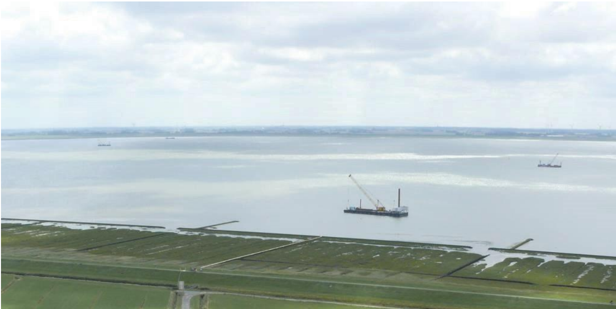
Abbildung 17: Beispielhafte Wasserbaustelle im Norderneyer Inselwatt (Quelle: MOLL-prd)
