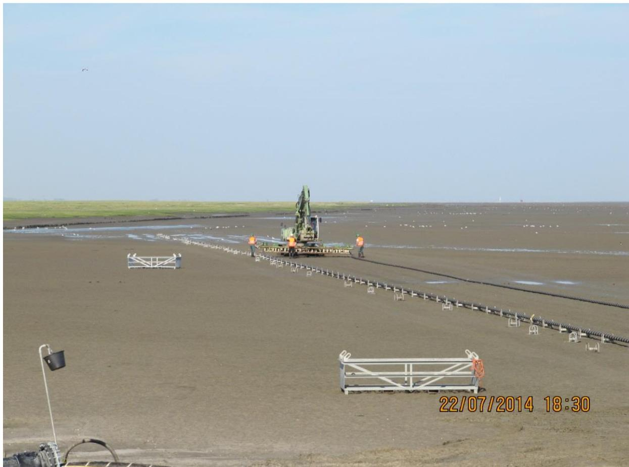
Abbildung 13: Auslegung der Kabelschleife (Quelle: eos projekt)
