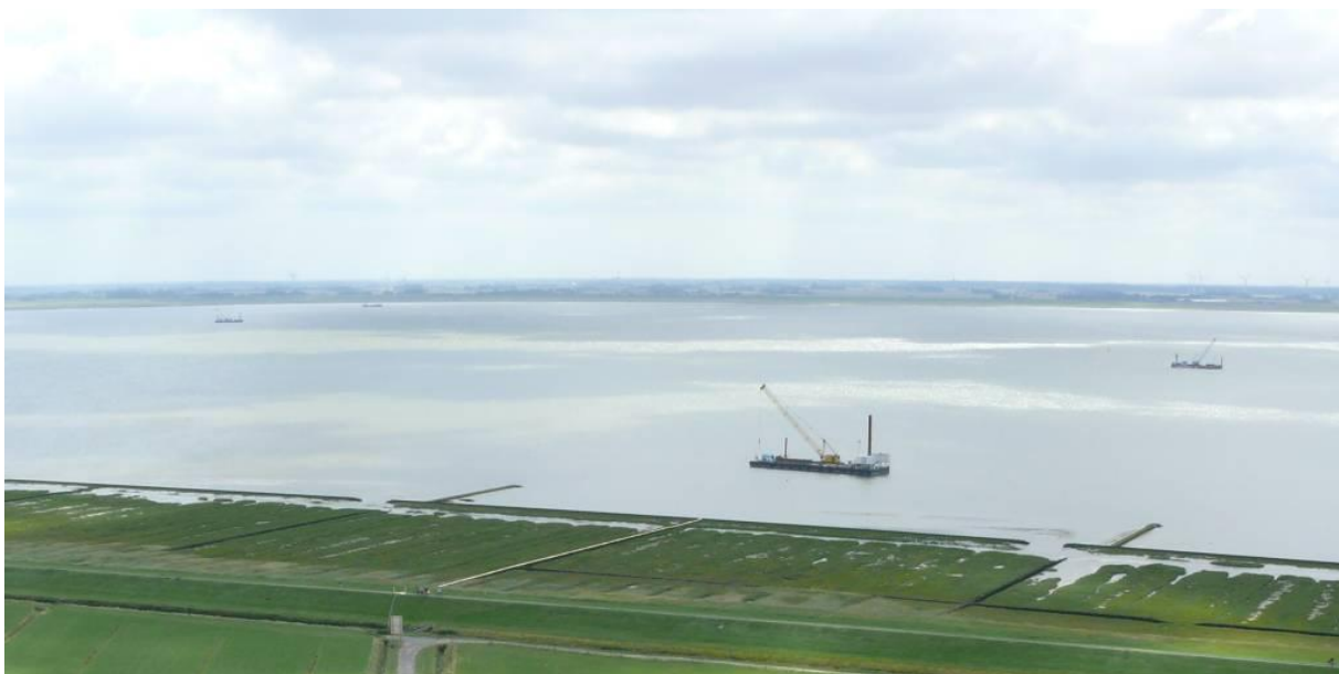
Abbildung 11: Beispielhafte Wasserbaustelle im Norderneyer Inselwatt (Quelle: MOLL-prd)
