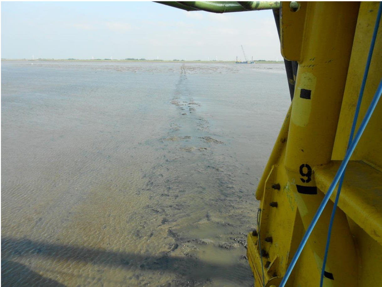
Abbildung 12: Kabelverlegung im Watt mit Hilfe eines Vibrationsschwertes (Quelle: eos projekt)
