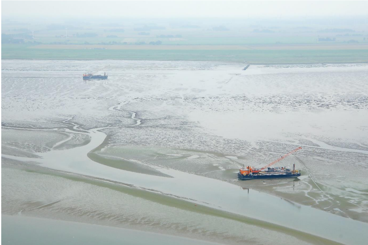
Abbildung 9: Luftbild einer exemplarischen Wasserbaustelle bei Hilgenriedersiel mit dem Arbeitspon- ton am Bohraustrittspunkt im Hintergrund und dem Anlege- und Fährponten am Riffgat- Fahrwasser im Vordergrund (Quelle: TenneT)
