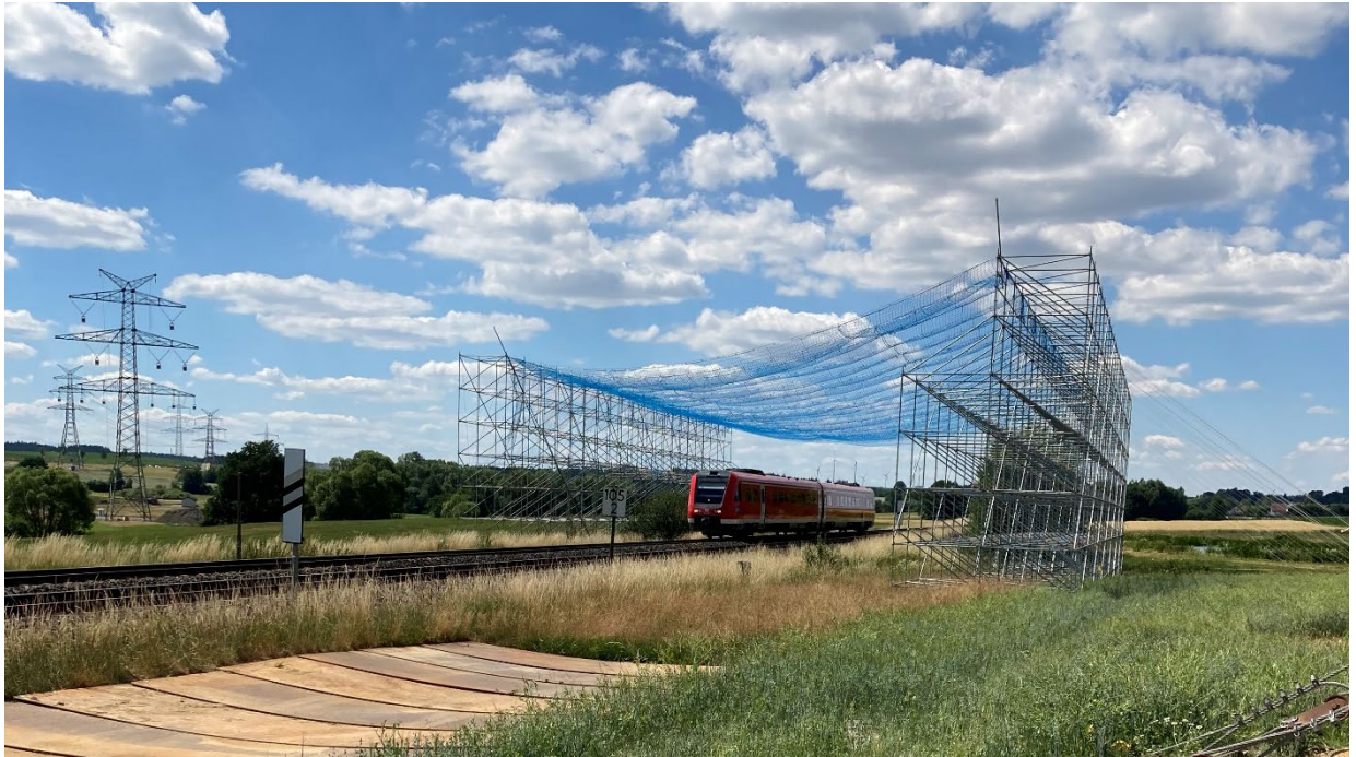
Abbildung 8: Beispiel für Schutzgerüste aus Stahl
