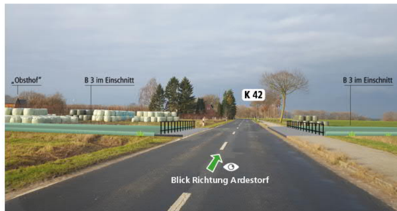
Blick Richtung Ardestorf: Die B 3 verläuft hier unterhalb der Geländeoberfläche und ist nicht zu sehen. Im Zuge der Kreisstraße (K 42) wird eine Brücke über die B 3 gebaut. Auf der Karte sind die Position und die Blickrichtung mit dem grünen Pfeil markiert.
