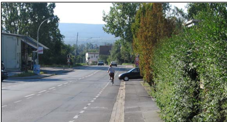
Zufahrt zum Supermarkt – Sichteinschränkung durch Bepflanzung
