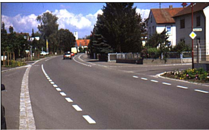
Bild 9: Irritierende Unterbrechung der Schutzstreifenmarkierung im Einmündungsbereich
