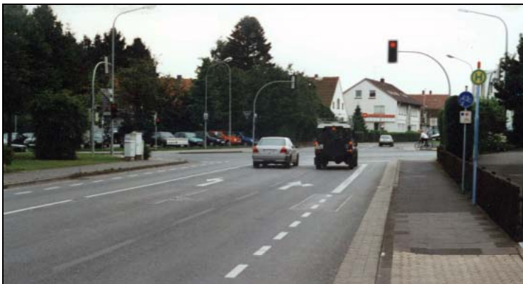
Führung in der Zufahrt an einem signalisierten Knotenpunkt
