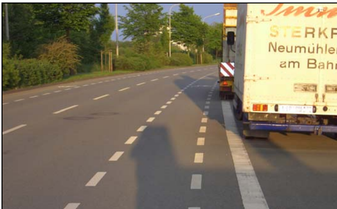
Bild 16: Breiter Parkstreifen für Lkw (2,50 m) mit zusätzlichem Sicherheitstrennstreifen zum Schutzstreifen
