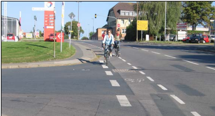
Schutzstreifen im Bereich einer Einmündung
