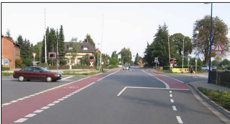
Rot gefärbter Schutzstreifen im Bereich des Bahnüberganges
