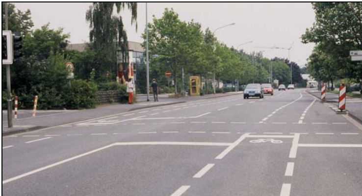
Vorgezogener Wartebereich an Fußgänger-LSA
