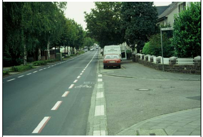
Bild 4: Troisdorf - Vorher schmaler gemeinsamer Geh- und Radweg, nachher Schutzstreifen (Troisdorf, L 322)
