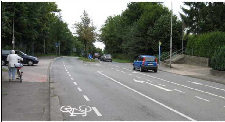
Querschnitt 2 – Schutzstreifen im Linksabbieger
