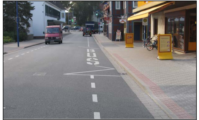
Bild 26: Unterbrochener Schutzstreifen an einer Bushaltestelle
