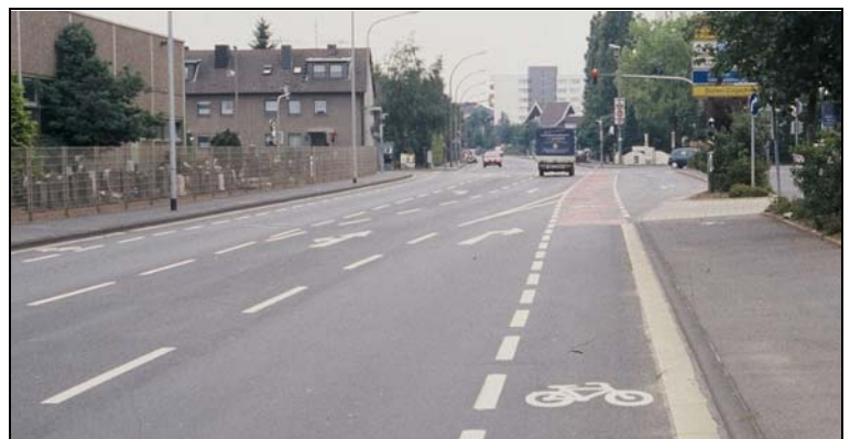
Schutzstreifen im oder am Knotenpunkt
