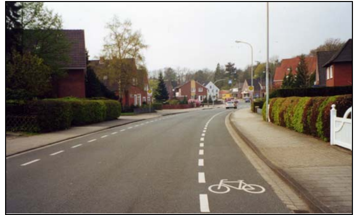
Bild 18: Regelmarkierung eines Schutzstreifens auf der Strecke
