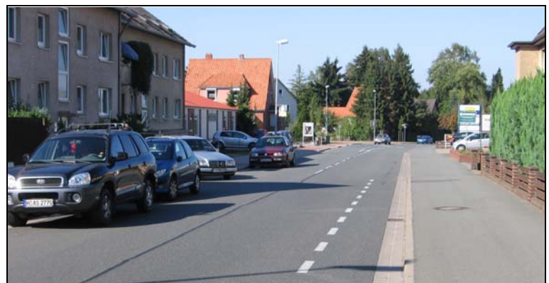
Unterbrechung des Schutzstreifens in Knotenpunkt
