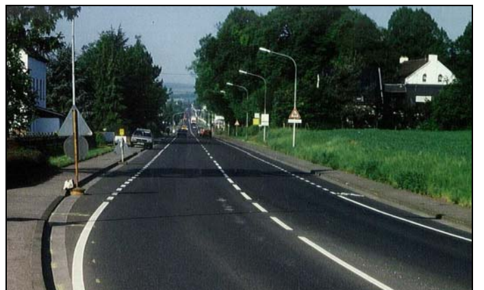
Bild 5: Beginn bzw. Ende der Schutzstreifen im Ortseinfahrtbereich (Roggendorf, Kreis Euskirchen, B 266)
