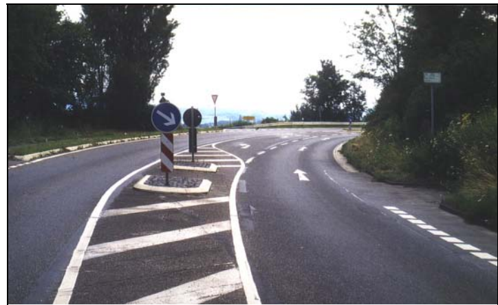
Bild 32: Geschützter Aufstellbereich am Fahrbahnrand und Mittelinsel zur Sicherung des Überquerens vom Schutzstreifen zum linksseitigen Zweirichtungsweg
