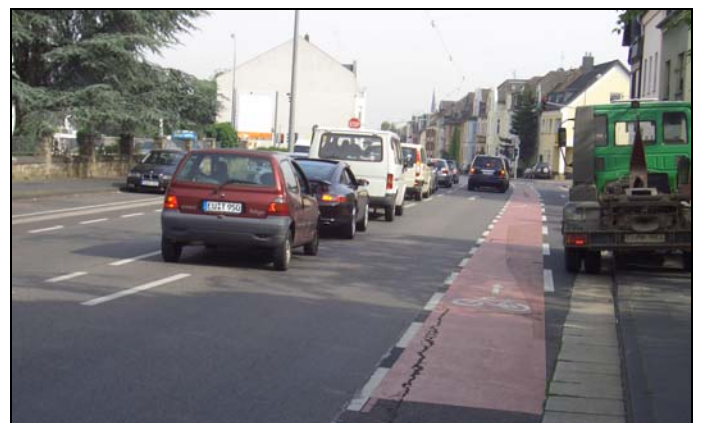
Bild 19: Roteinfärbung eines Schutzstreifens zwischen Geradeaus- und Rechtsabbiegestreifen
