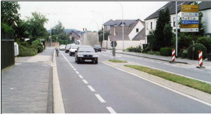
Schutzstreifen im Bereich eines Fahrbahnteilers
