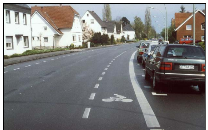
Bild 14: Markierung eines Schutzstreifens neben Längsparkständen
