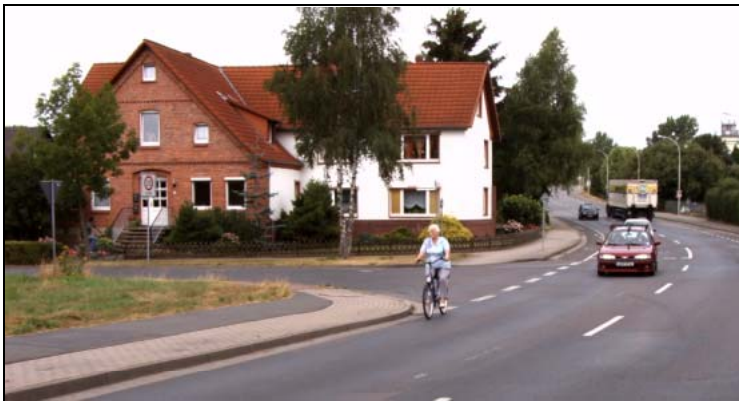
Ungünstiges Ende des Schutzstreifens im Einmündungsbereich
