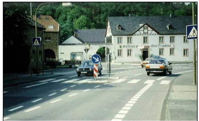
Bild 7: Nicht den Vorgaben entsprechende Markierung eines Schutzstreifens mit unterbrochenem Breitstrich
