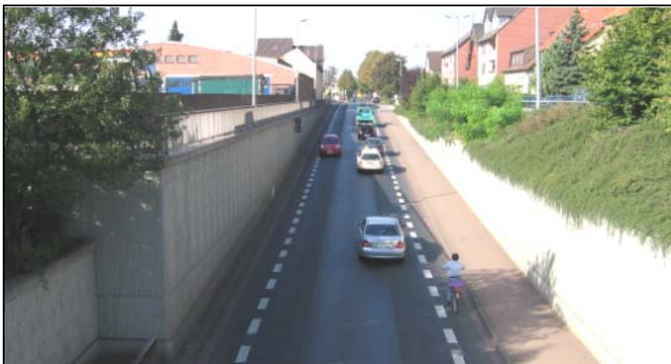
Schutzstreifen im Bereich einer Unterführung
