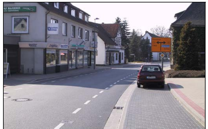
Bild 13: Längsparkstreifen mit Rinne neben dem Schutzstreifen
