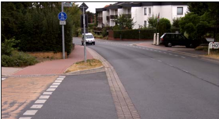
Ungünstiges Ende des Zweirichtungsradweges in Kurvenbereich
