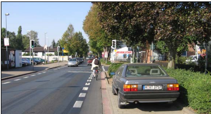
Nicht regelkonforme Markierung - Breitstrich
