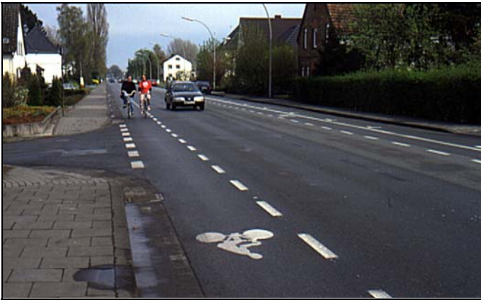
Bild 8: Markierung eines Radfahrstreifens mit nicht normgerechtem Piktogramm
